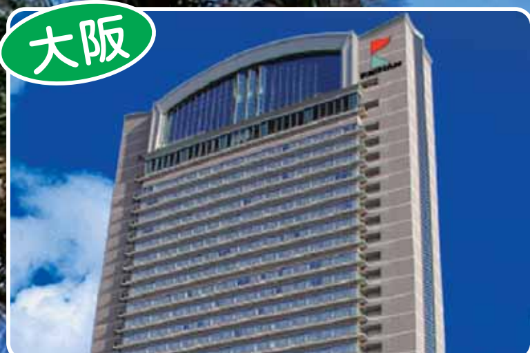
ホテル京阪 ユニバーサル・タワー
